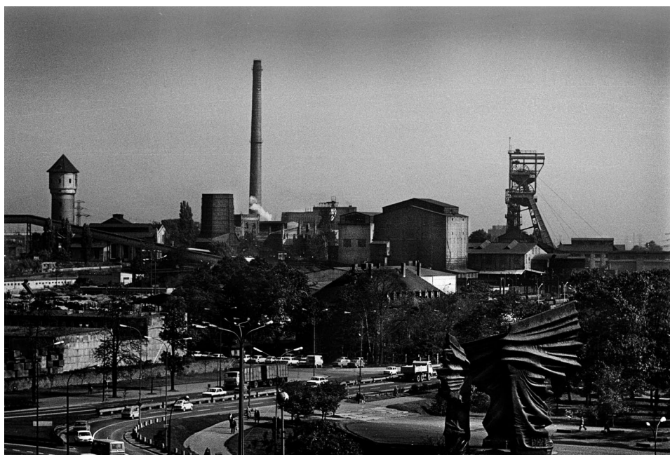
Józef Ligęza, Widok na kopalnię „Katowice” w Katowicach, [1974]
