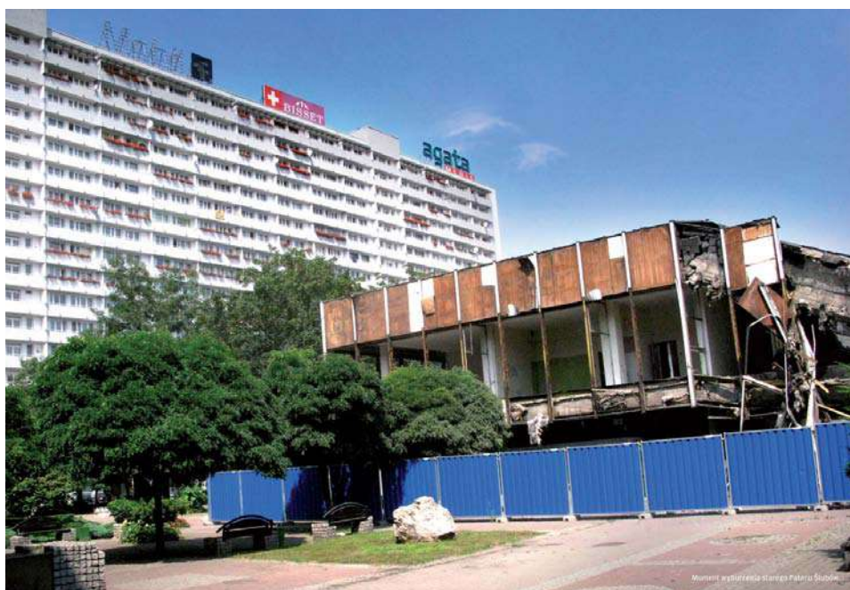
Józef Ligęza, Wyburzanie Pałacu Ślubów w Katowicach , 2011, sygnatura: Fot. 15322 III
